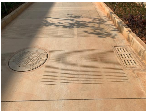
道路两侧雨水口、雨水井
