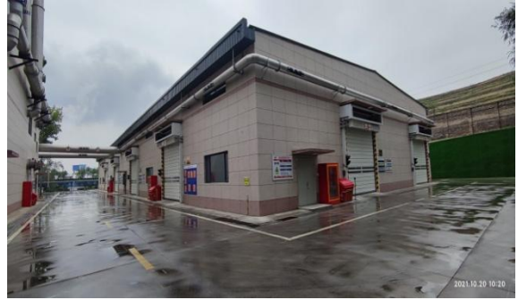
危废储库废气集气管
