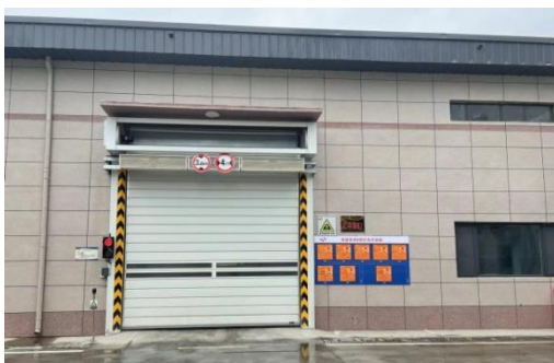
危废储库外部
