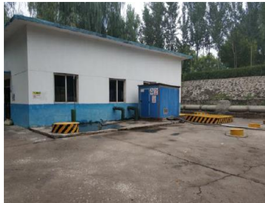
生活污水处理站
