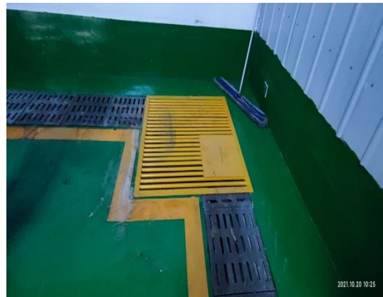
危废储库内集水坑
