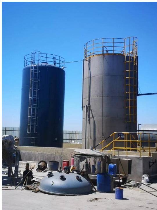
三甲氧储罐及废气收集管道
