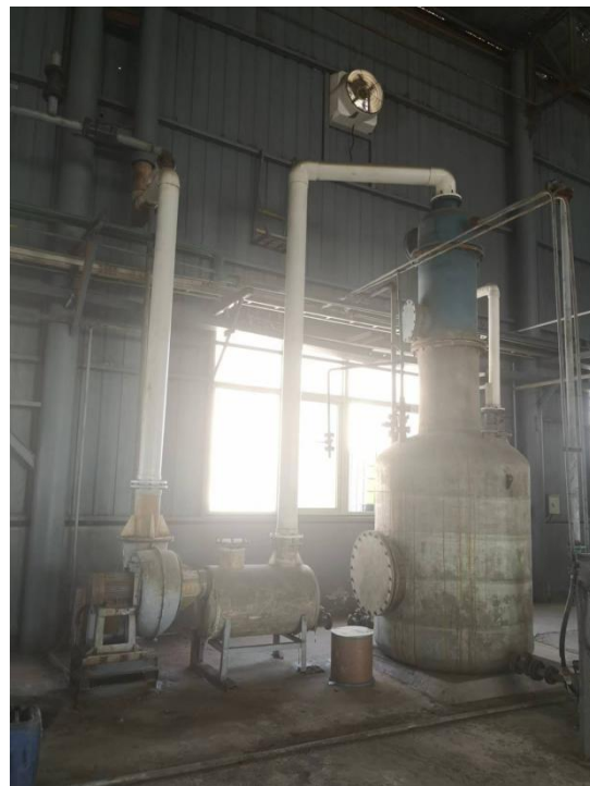
喷淋塔+除雾器+二级活性炭吸附装置
