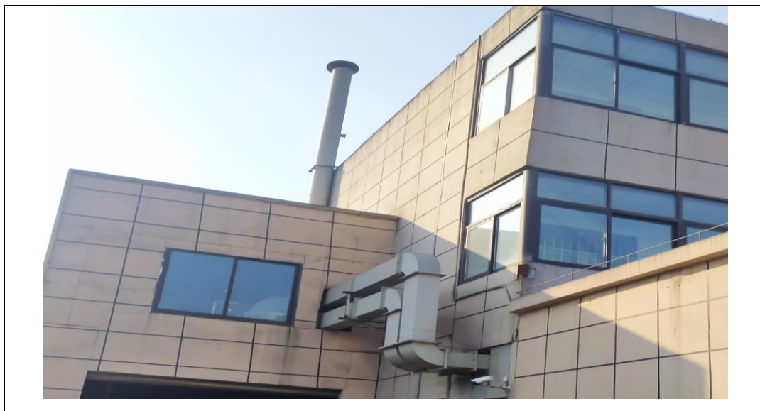
图 4.1-2 废气收集及治理设施装置图
