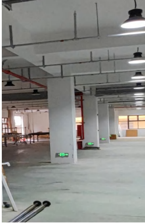
图 2-3 车间现场照片
