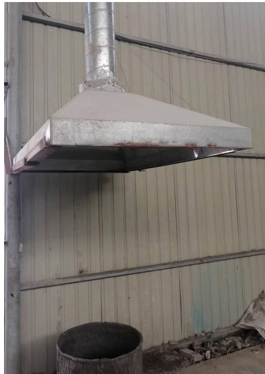
制浆搅拌工序集气罩
