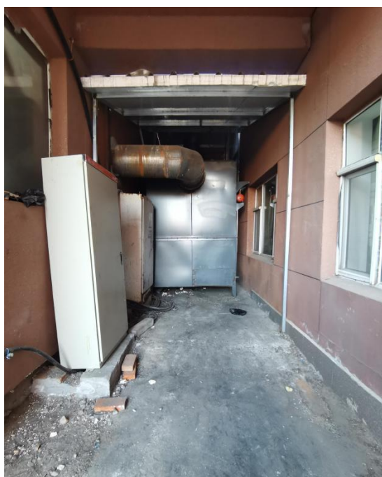
2.8MW 锅炉布袋除尘器
