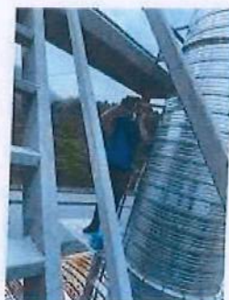
发泡工序废气排气筒 (处理后)
