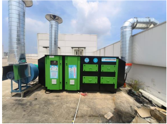
发泡有机废气：活性炭+催化氧化
