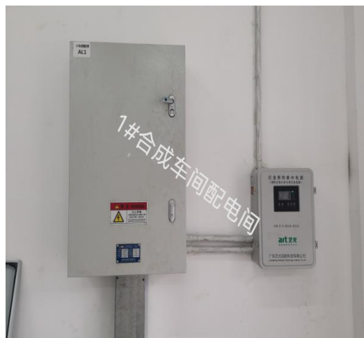
1#合成车间辅机房（应急照明电源）
