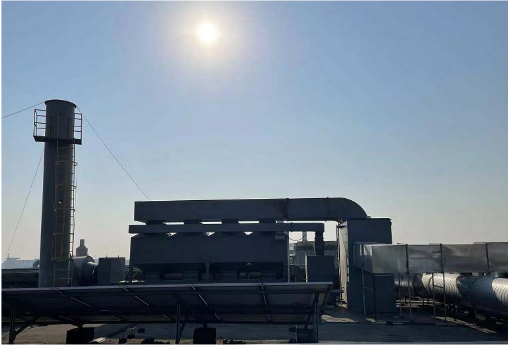
图2-4 企业印刷、设备清洗、复合、调墨废气处理设施图片（干式预过滤器+活性炭吸附脱附+催化燃烧净化装置（RCO））
