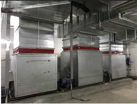
风机房减振基座、软连接
