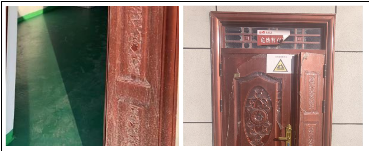
图4.2-4 危险废物暂存间
