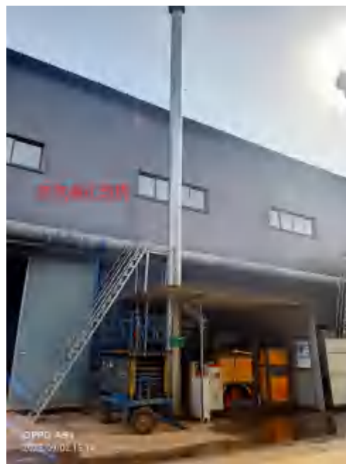
干式过滤+吸附+脱附+催化燃烧（电加热）TA002+1 根 15m 排气筒 DA002
