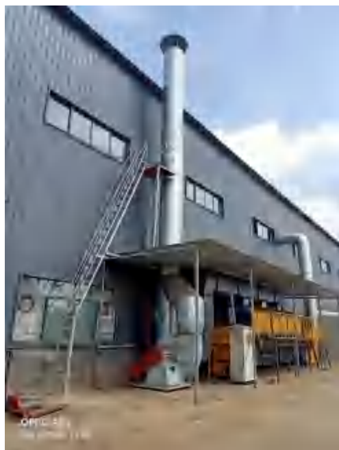
干式过滤+吸附+脱附+催化燃烧（电加热）TA001+1 根 15m 排气筒 DA001
