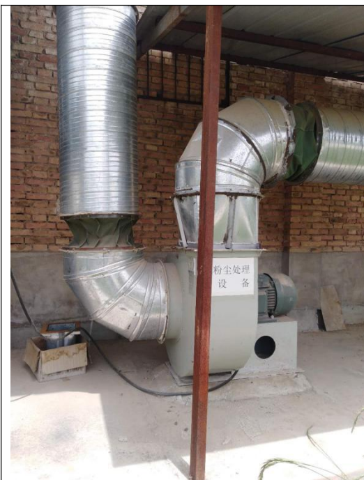
图 3-5 风管软接头
