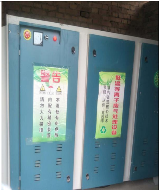
图 3-2 UV 光氧催化装置+活性炭吸附装置（设备间内）
