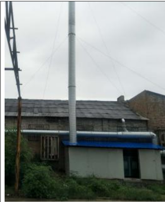
图 3-1 UV 光氧催化装置+活性炭吸附装置（设备间外）
