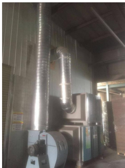
图 3-6 预印刷车间活性炭棉吸附棉装置+UV 光氧催化装置
