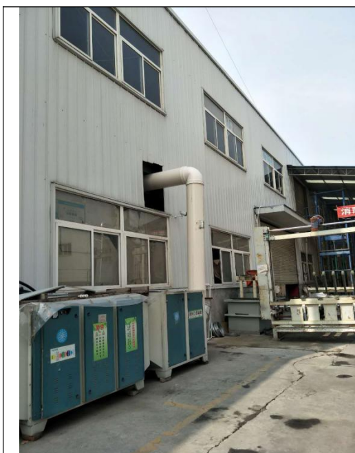
图 3-3 印刷车间活性炭棉吸附棉装置+UV 光氧催化装置
