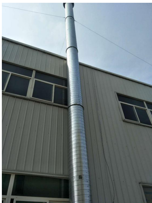
图 3-5 印刷车间排气筒
