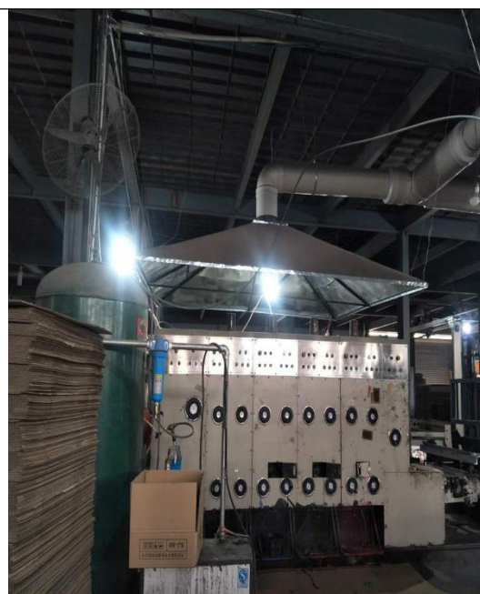
图 3-4 印刷车间集气罩
