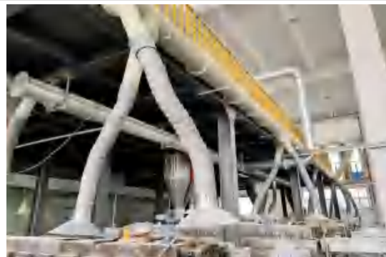
造粒废气收集管道
