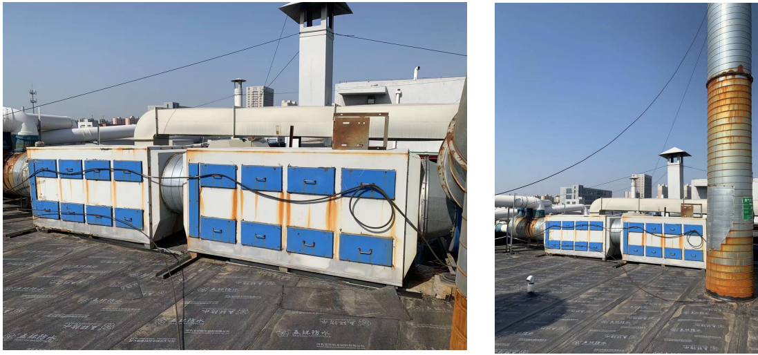
图 3-2 废气治理设施及排放口照片
