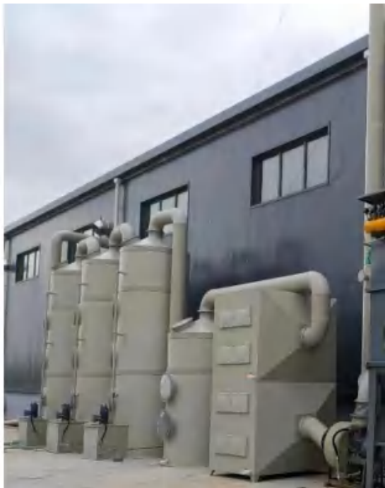
图 4-5 烷基化、磺化、中和、冷凝、混配废气治理设施（酸洗+碱洗+水洗+水气分离装置+两级活性炭吸附）及 15m 高排气筒（DA002）
