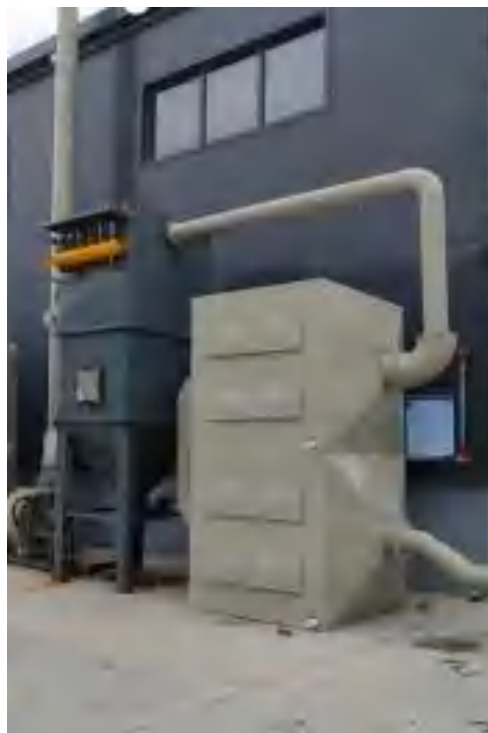
图 4-2 萘破碎、投料废气:布袋除尘器+二级活性炭+15m 高排气筒(DA001)
