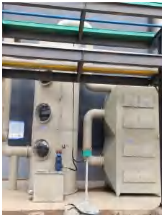
图 4-7 危废间、储罐呼吸废气治理设施（碱洗+两级活性炭）
