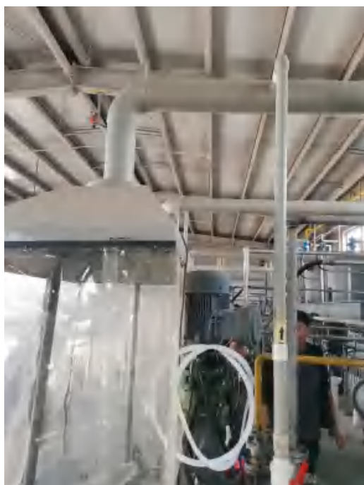
图 4-3 烷基化、磺化、中和、冷凝、混配废气釜顶放空管收集装置
