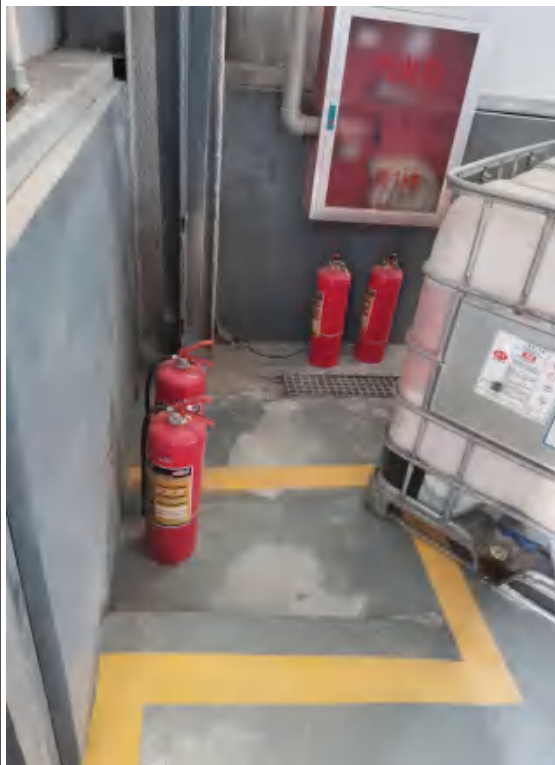
图 4-12 危废间-消防设施及导流槽
