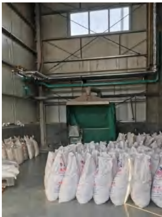
图 4-1 萘破碎、投料废气:集气罩
