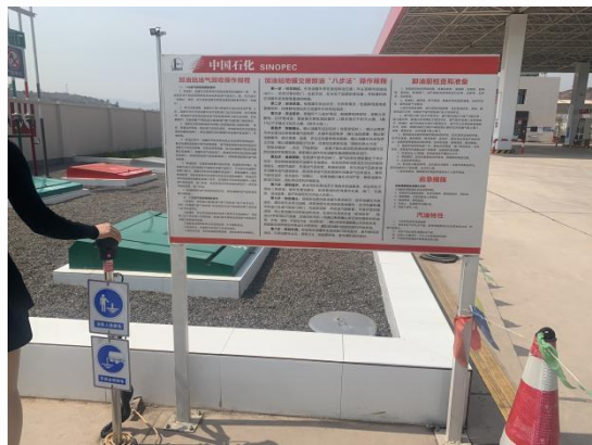
卸油口释放静电装置
