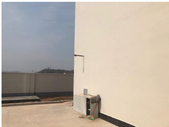
发电机废气排口
