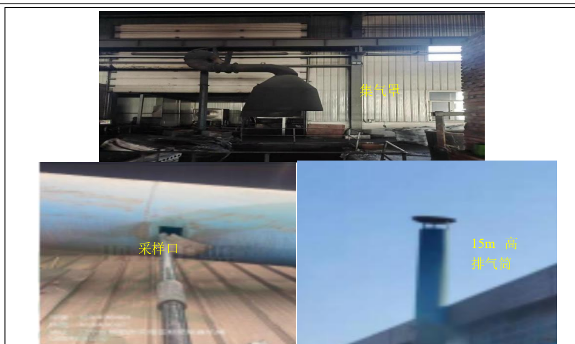
图 3-2 中频电炉采样口、集气罩及排放口
