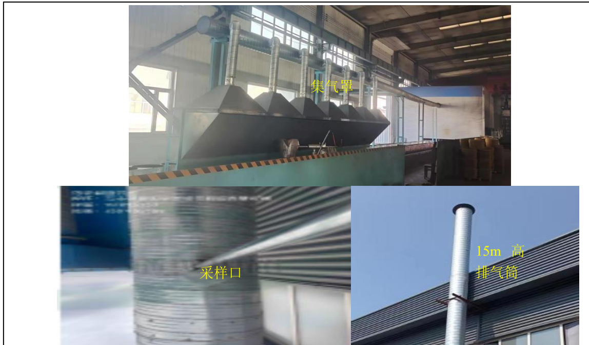
图 3-4 浇注集气罩、采样口及排放口
