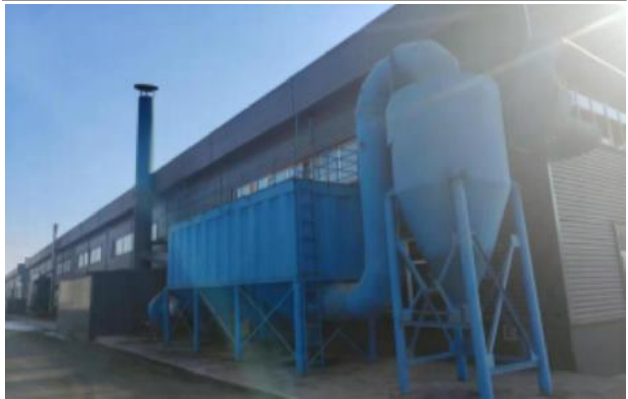
图 3-1 中频电炉旋风及布袋除尘器
