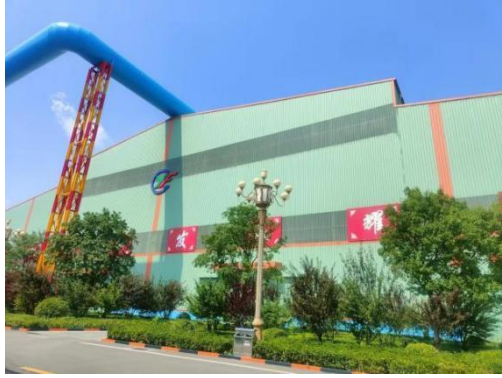
双层彩钢加隔音棉建筑，车间全封闭
