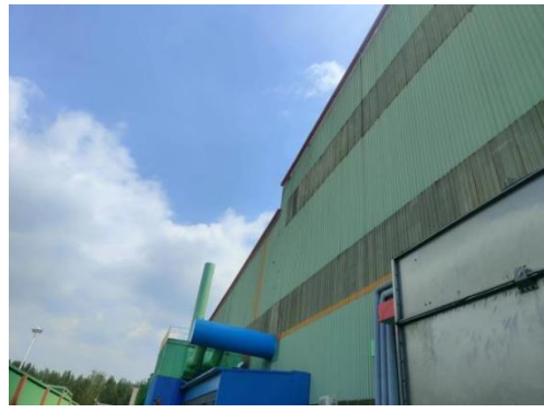
双层彩钢加隔音棉建筑，车间全封闭
