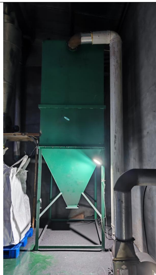
图 1、布袋除尘器+碱液喷淋塔
