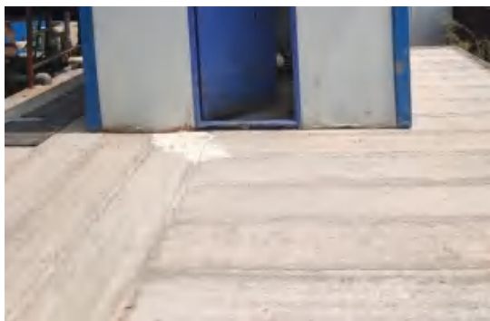
脱硫循环水池
