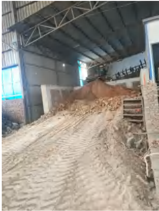
厂房内进料口
