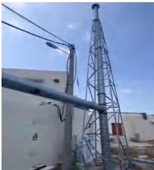
污水处理站废气排气筒（15m）
