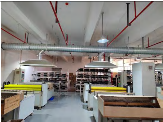
全自动纤维棒生产线上方的集气罩现场照片
