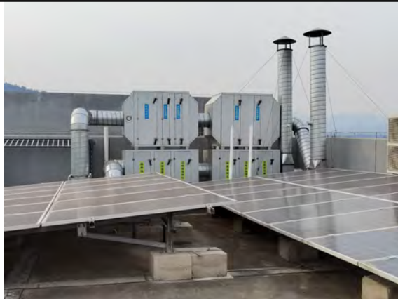
干式过滤+二级活性炭吸附装置现场照片（位于厂房楼顶）
