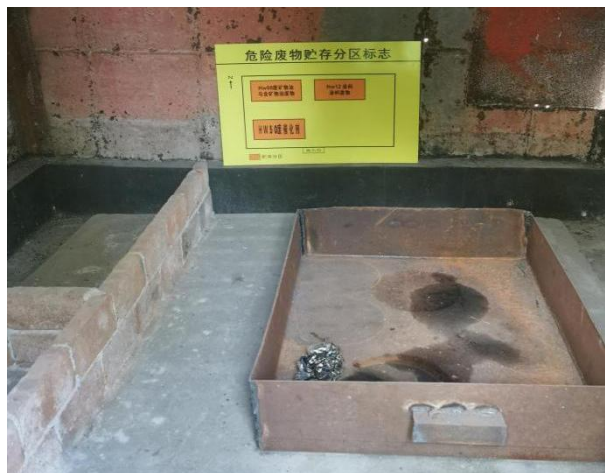
危废暂存间内部（危废分区）
