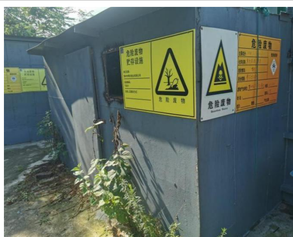
危险废物暂存间
