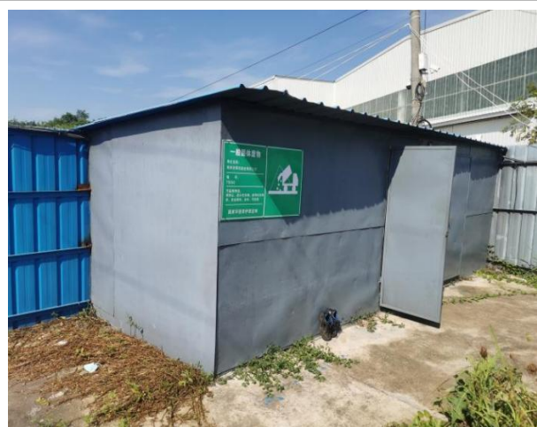
一般固废暂存间
