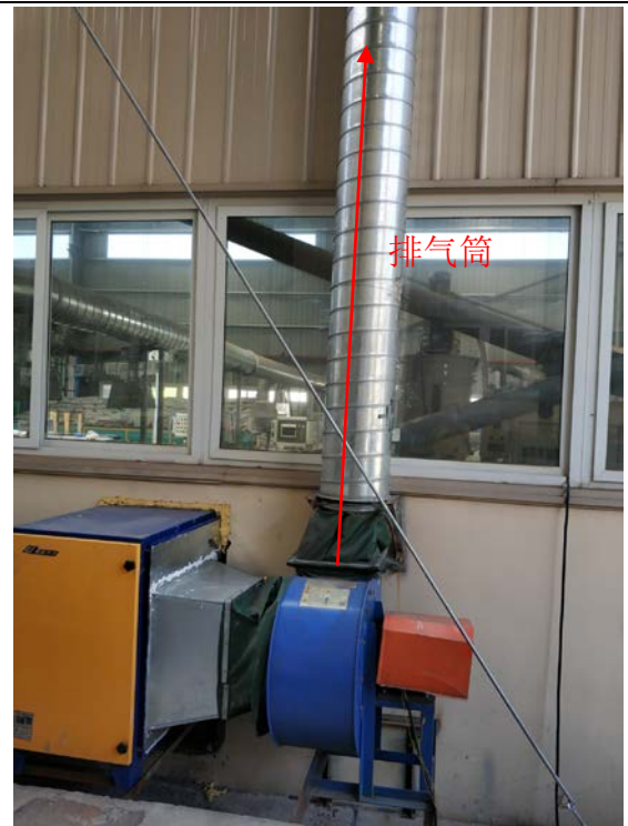
排气筒（挤塑废气）
