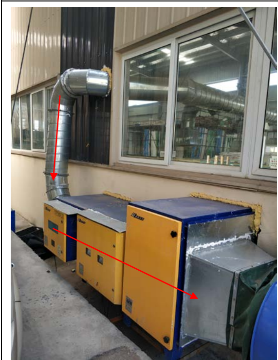
废气治理措施 （油烟净化器+活性炭吸附+UV 光解）
