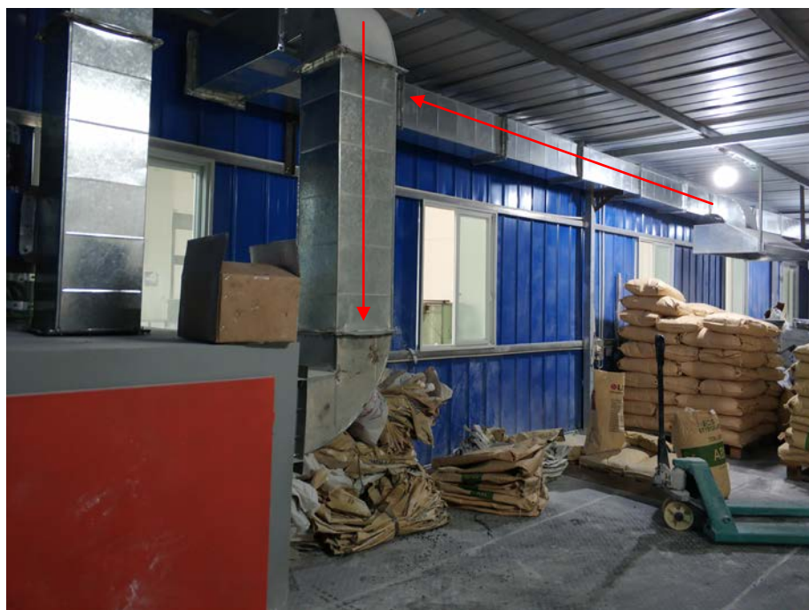
废气收集管道（投料/混料工序）
