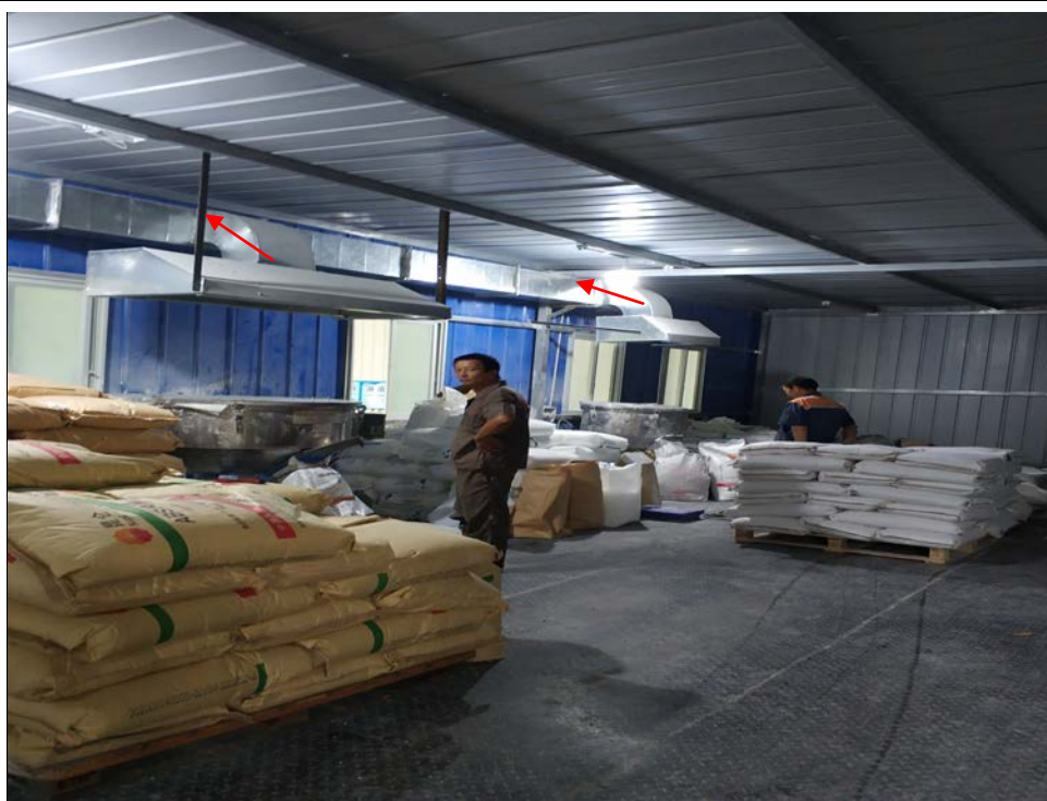
集气罩（投料/混料工序）
