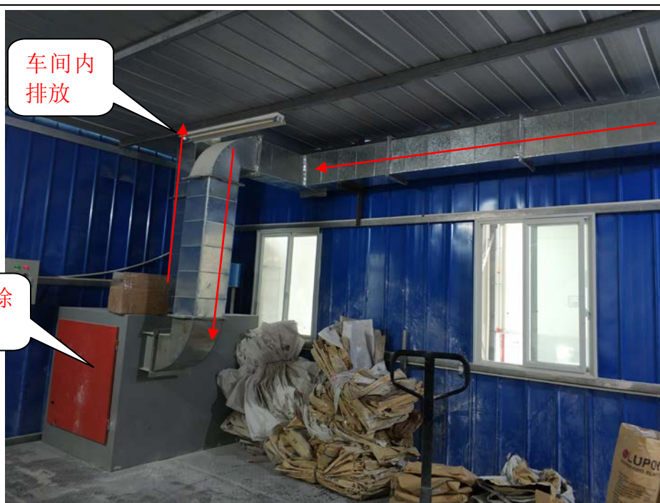
废气收集、处理设施（投料/混料工序）
