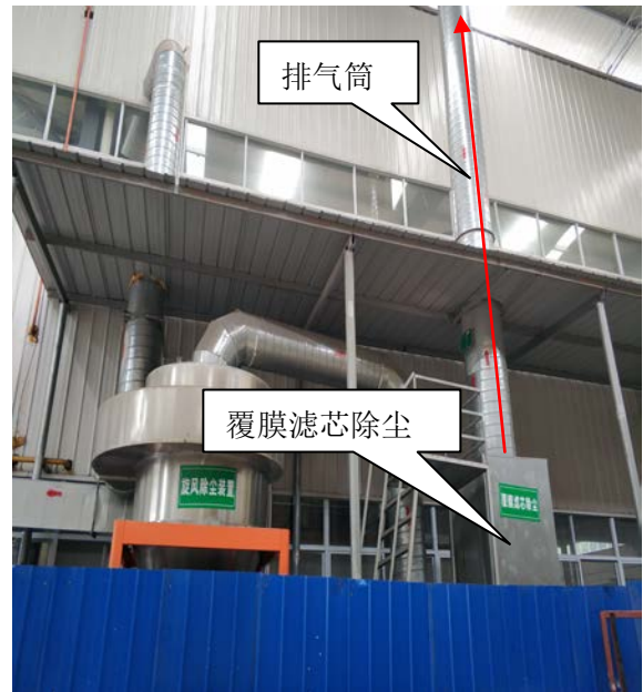
覆膜滤芯除尘装置（自动喷塑）
