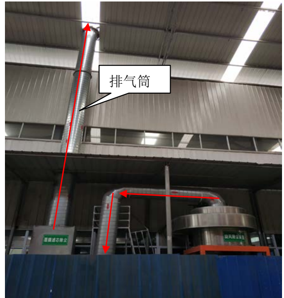
大旋风除尘装置+覆膜滤芯除尘（手动喷塑）
