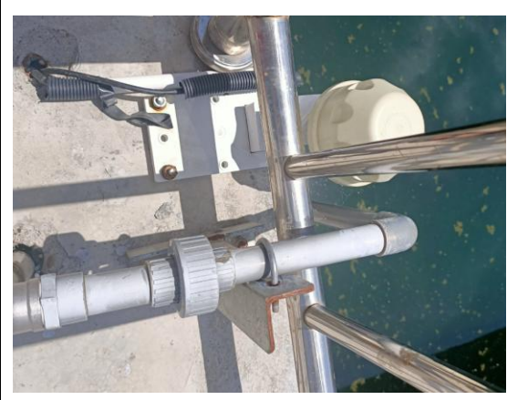
接触池出水口流量监测仪
