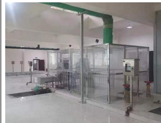
格栅池集气罩、集气管道
