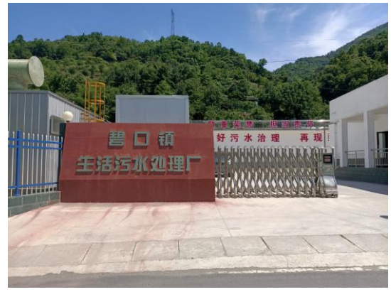
碧口镇生活污水处理厂
