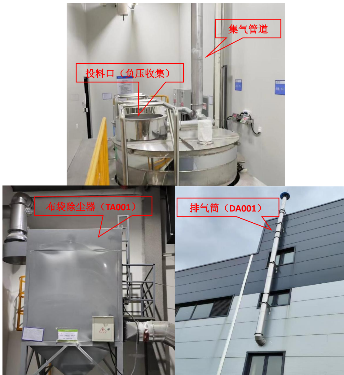
图 4 布袋除尘器 (TA001) 及排气筒 (DA001)
