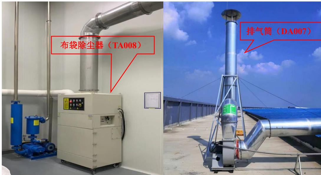
图 9 布袋除尘器 (TA008) 及排气筒 (DA007)
