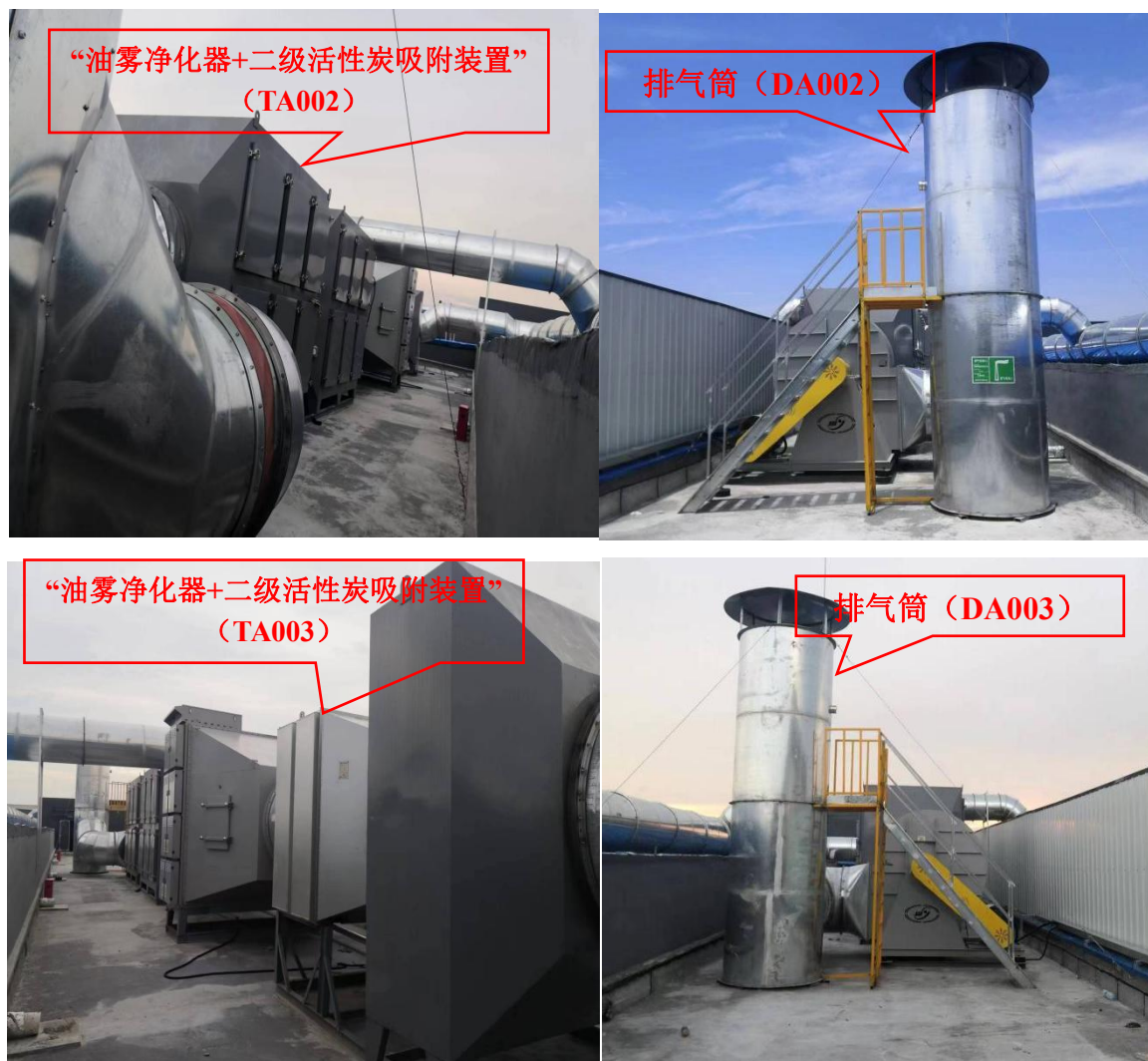
图 5 “油雾净化器+二级活性炭吸附装置”（TA002、TA003）及排气筒（DA002、DA003）
