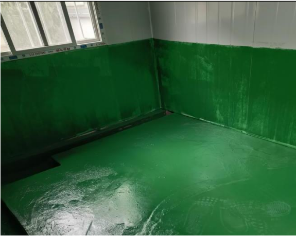
危废暂存间内部（防渗等）
