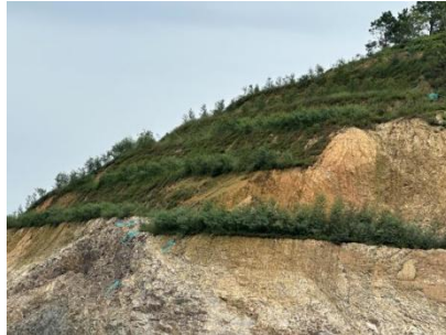
破碎加工区东南侧边坡
