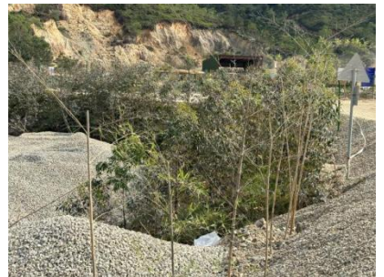
破碎加工区边坡
