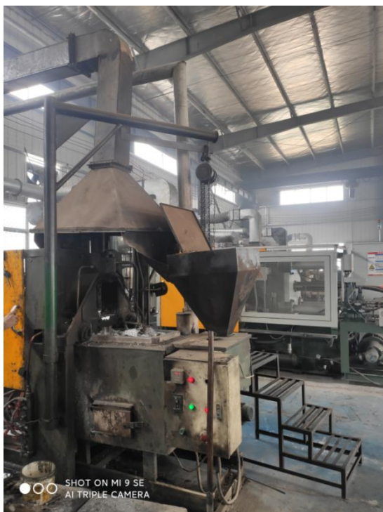
熔炼铸造废气集气装置
