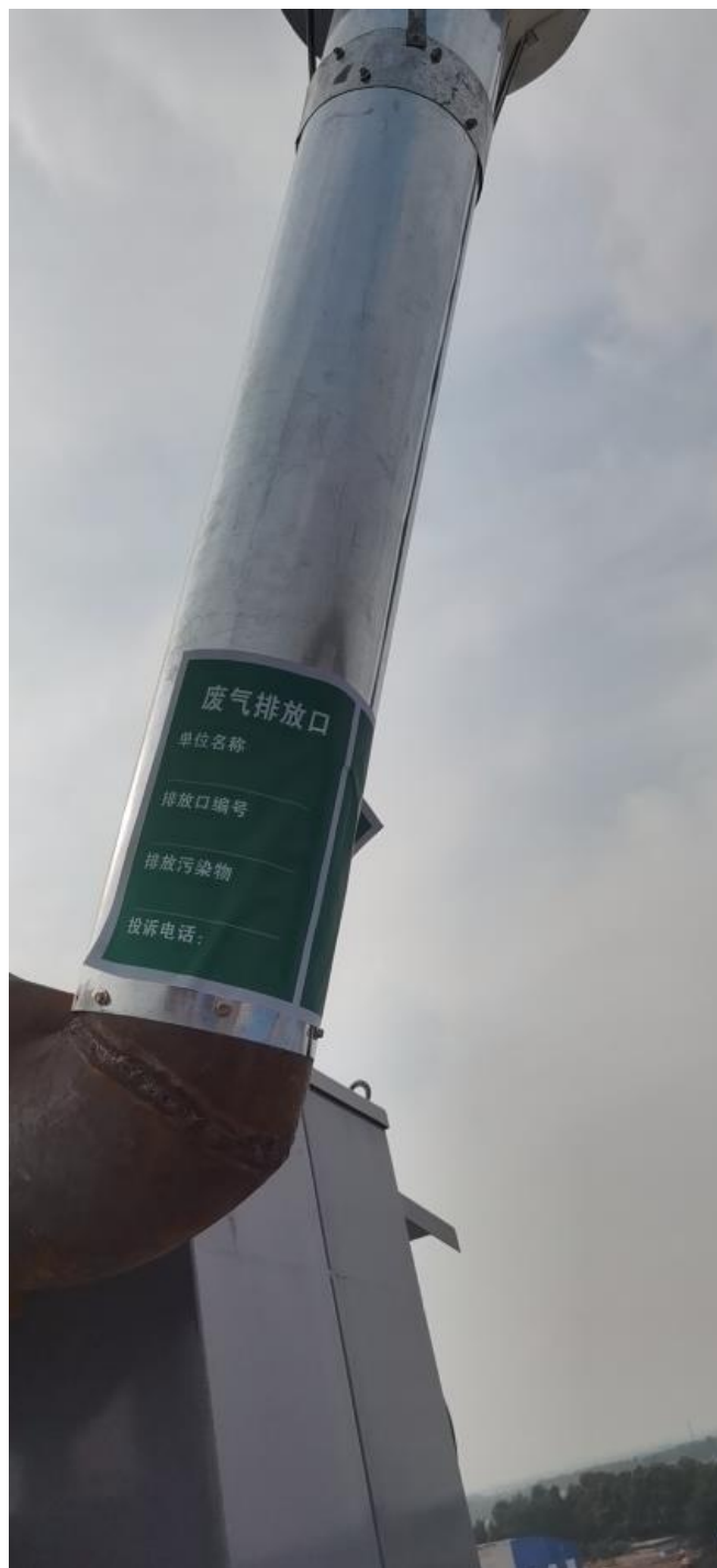
图 3-4 粉煤灰仓顶布袋除尘器+排气筒
