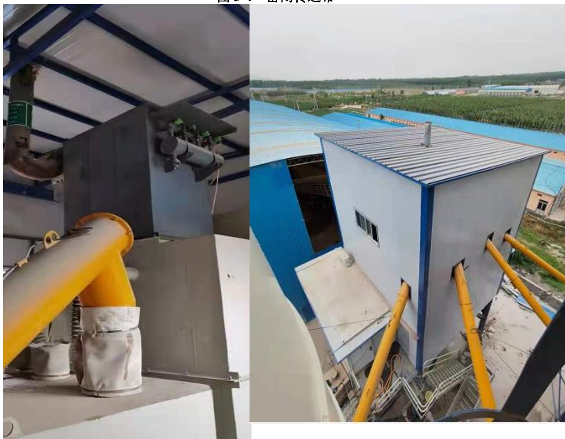
图 3-4 布袋除尘器+排气筒
