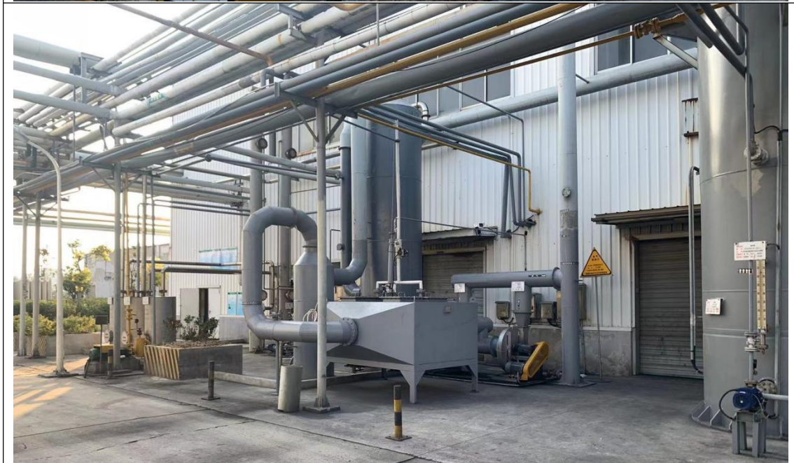
三废处理区：废水处理设施上方均已加盖，废气处理设施已设置围堰，地面完好无明显破损裂痕。
