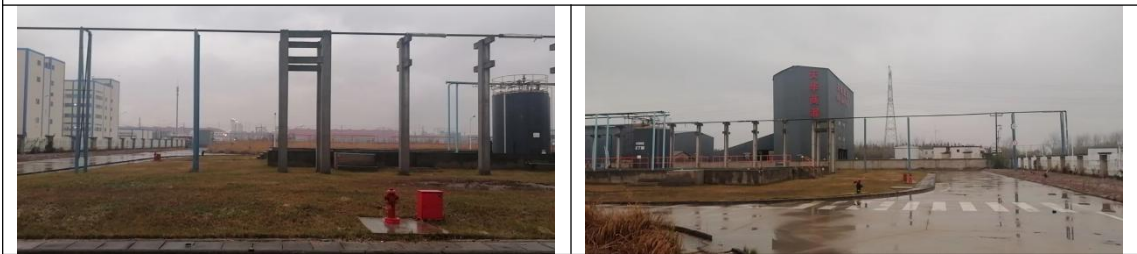
仓储区：储罐区均设置有隔水围堰，地面完好无破损。
