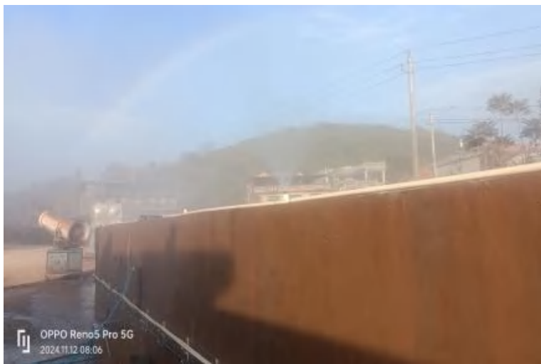
厂区围墙喷雾洒水装置
