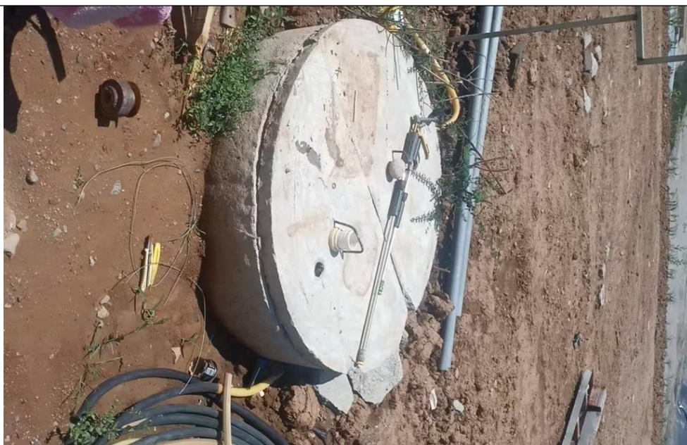
地下水监测井
