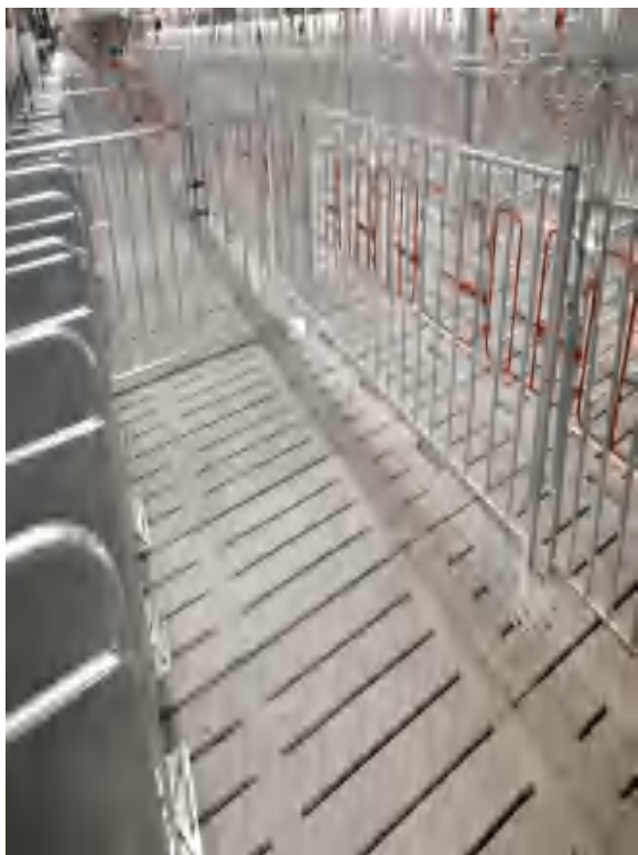
29 场猪舍漏缝地板
