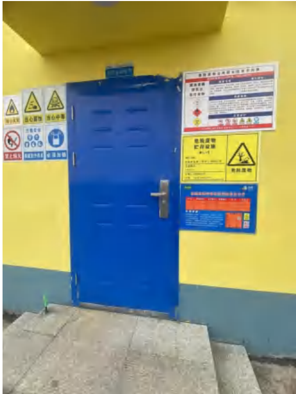
27 场危废暂存点
