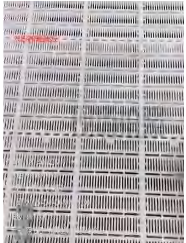
28 场猪舍漏缝地板
