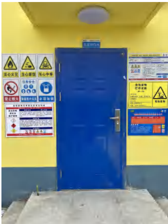
29 场危废暂存点
