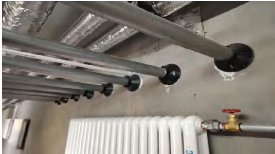
29 场饲料输送管道密闭
