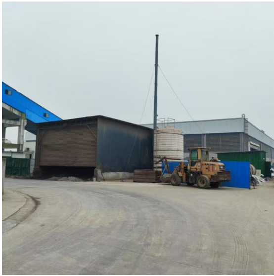
底渣库排气筒
