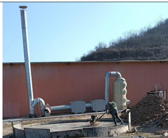
干湿分离间恶臭经微负压收集+喷淋塔+15m 高的排气筒
