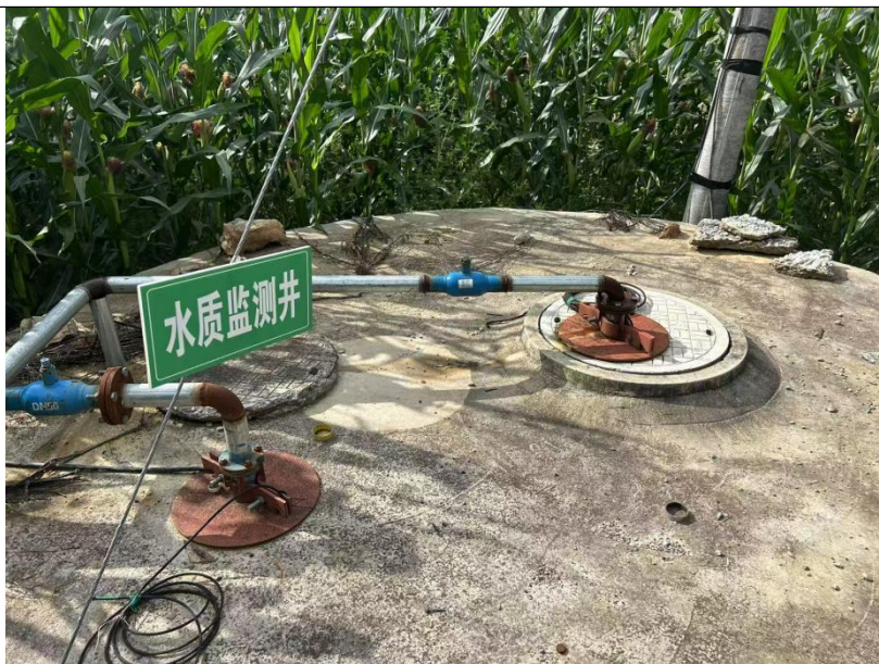
地下水监测井
