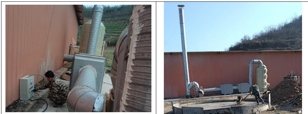
15m 高的排气筒（DA001）
