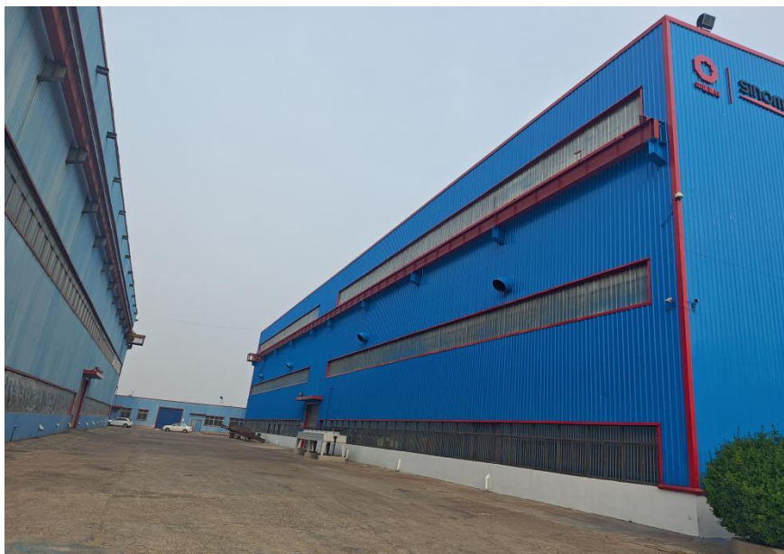
厂房密闭（依托项目）
