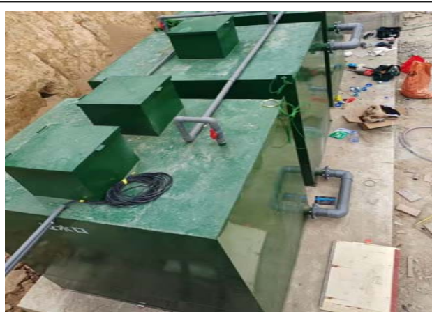
污水处理设备（施工时拍摄）
