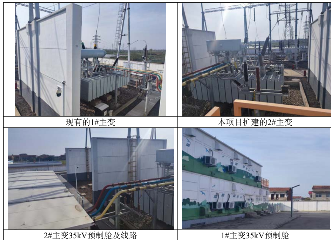
图4-3 工程现场照片
