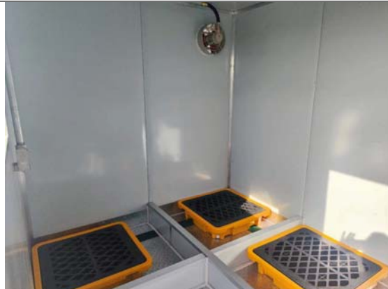
危废暂存间内部设置
