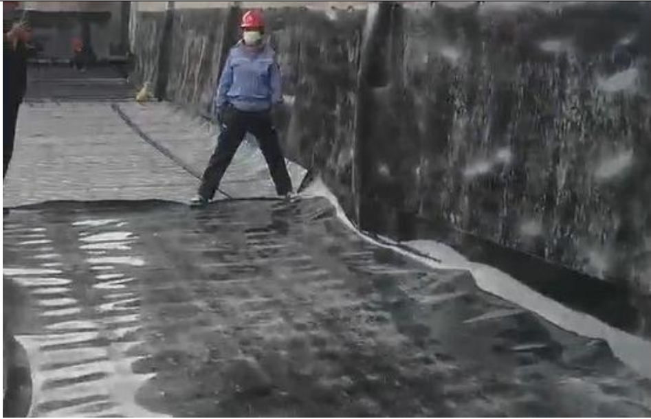
地坪及侧墙高密度聚乙烯防渗膜施工
