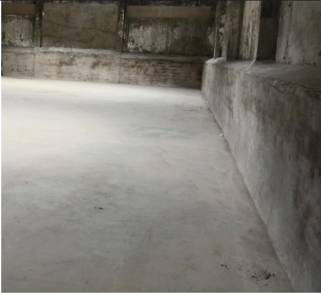
地面和侧墙 1500 高度防渗处理后
