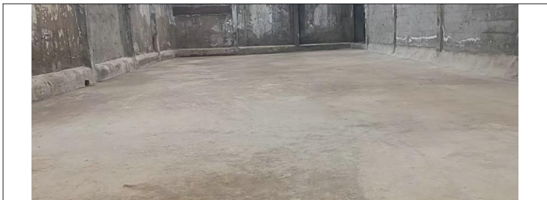
地坪基础 600mm 黏土垫平层施工
