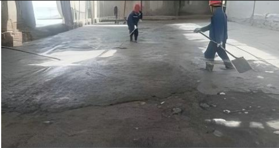
新三合土覆盖（100mm 厚）及 1:3 水泥砂浆覆盖（50mm 厚）施工
