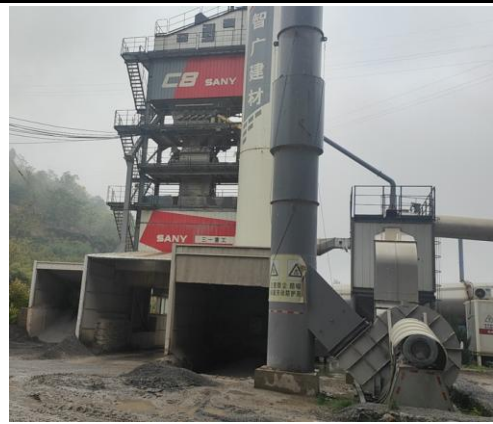
布袋除尘器 15m 高排气筒
