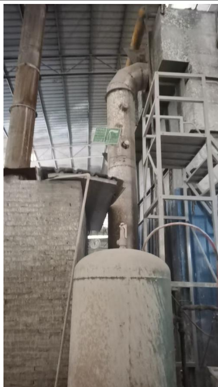
干燥机废气排气筒 (FQ-16217-1)
