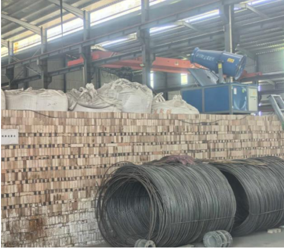
全封闭车间+雾炮装置
