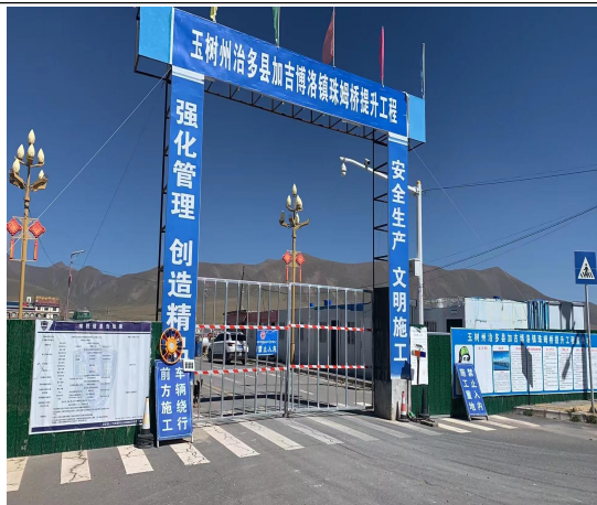
施工期临时设施
