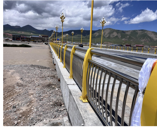
桥梁路面护栏
